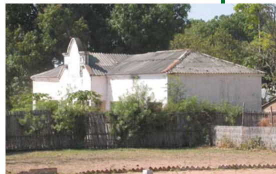
L'edificio che sarà ristrutturato: i lavori riprenderanno nella prossima primavera.
