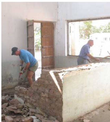
Alpini al lavoro per la rimozione delle macerie nell'edificio che diventerà un collegio femminile.
